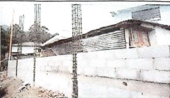
Foto 3: Sustitución muro perimetral 30 mts.
