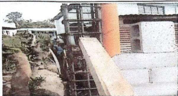
Foto 1: Sustitución muro perimetral 10 mts.
