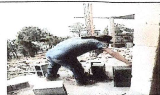
Foto 5: Sustitución muro perimetral 20 mts.
