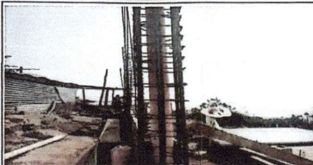
Foto 2: Sustitución muro perimetral 30 mts.
