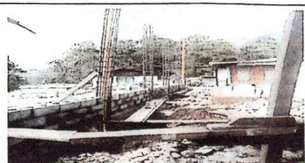
Foto 6: Sustitución muro perimetral 50 mts.
